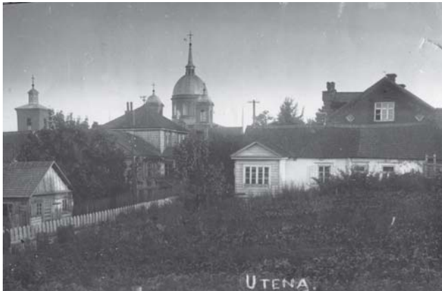
Kęstučio gatvė, jos gale Utenos bažnyčia, Utena 1930 m. (UKM 13374/F 862)
