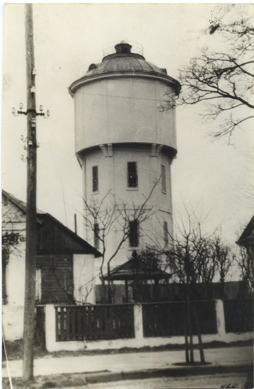
3 iliustracija. Ukmergės vandentiekio bokštas, XX a. 4 deš. (Ukmergės kraštotyros muziejus, UkKM F 36/1).
